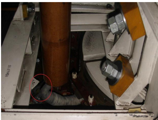
Рис. 6. Диагностированный «источник» повышенной разрядной активности
