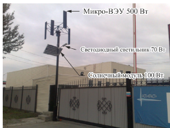
Рис. 2. Гибридный ветросолнечный энергокомплекс на основе микро ВЭУ
