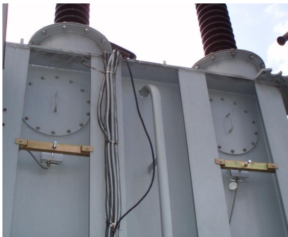
Рис. 3. Крепление акустических датчиков ЧР на корпусе трансформатора
