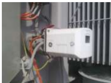
Рис. 5. Подключение анализатора газов Hydram M2
