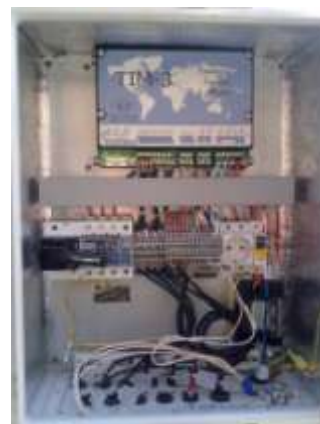
Рис. 4. Установка диагностического оборудования на трансформаторе ЦЭСиП
