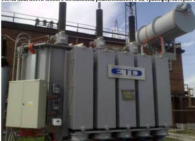
Рис. 4. Установка диагностического оборудования на трансформаторе ЦЭСиП
